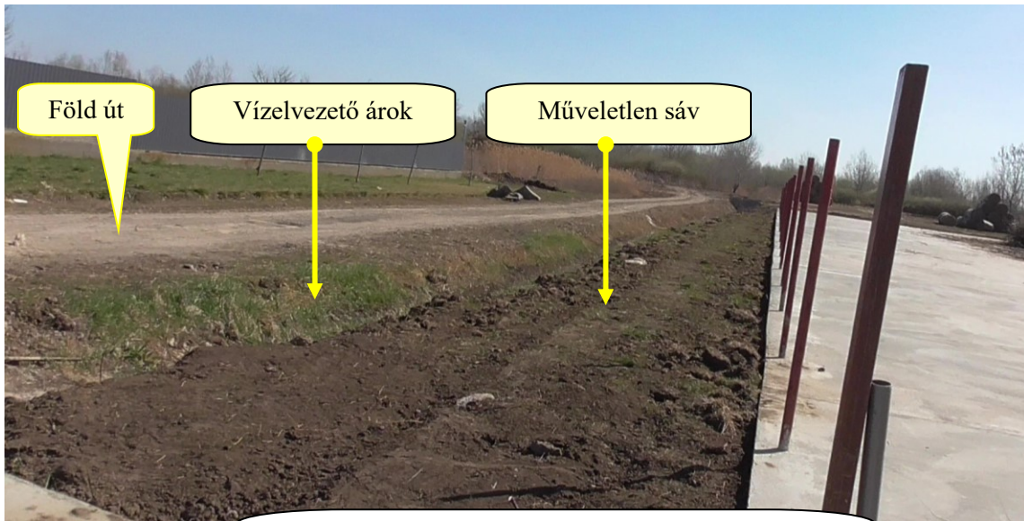
3/. kép A betonozott tároló terület és földút közötti terület.
