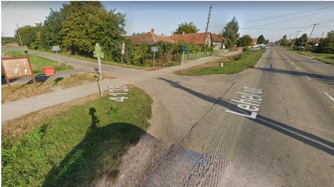
2.2.2. ábra 4138 j. út 49. sz. főút meglévő csomópontja, 49-es főúton nincs kanyarodó sáv, a 4138 j. út kiépítettsége nem megfelelő, annak korszerűsítése szükséges
