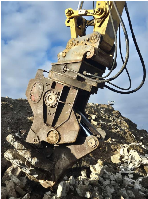
2. ábra Roppantó-bontó olló munka közben
