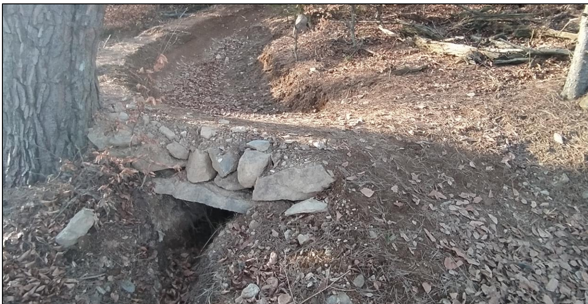
30. ÁBRA VÍZELVEZETÉS KŐBŐL ÉPÍTETT CSATORNÁVAL
