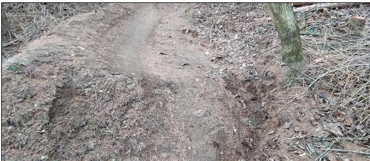
32. ÁBRA VÍZELVEZETÉS ÁROKKAL
